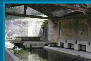
Lavoir de Badorit à Tourteron, impasse de Badorit
